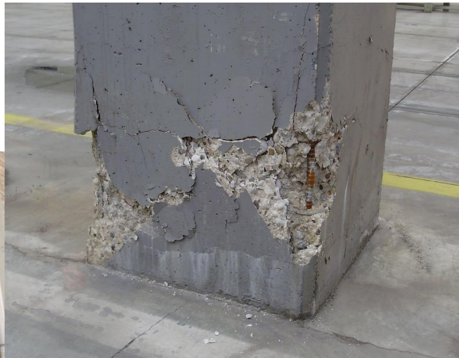
Danno D4/D5 - pilastro in c.a.
