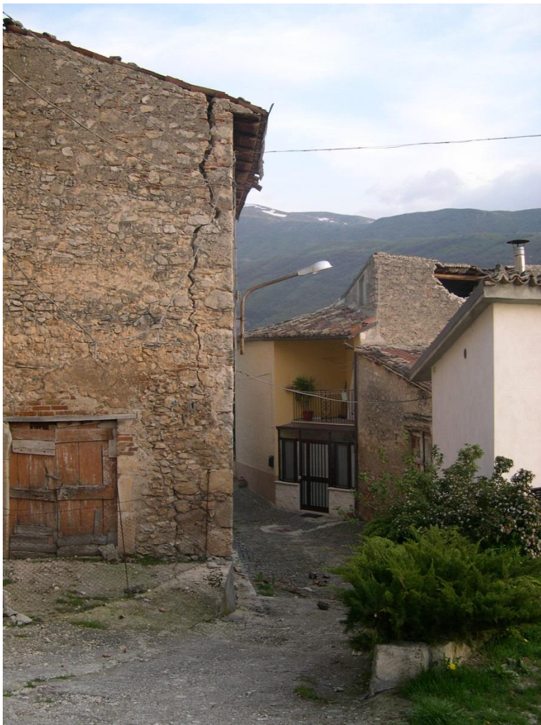
Danni D4/D5 –attivazione di cinematismi di ribaltamento fuori dal piano
