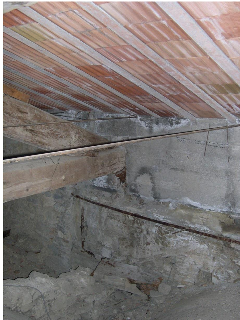
Danno D4/D5- appoggio al limite del crollo per rottura della mensola
