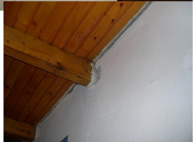
Danno D2-lesione su solai. In termini strutturali la gravità va valutata anche in relazione a cinematismi fuori piano della parete
