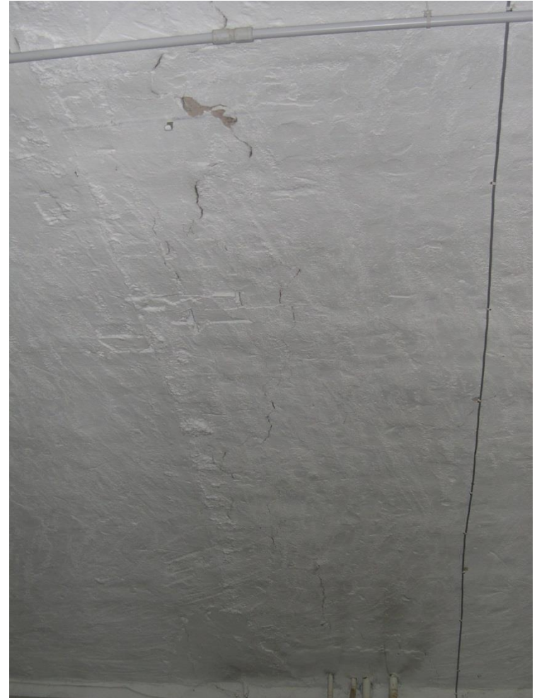
Danno D1-lesione ortogonale alla generatrice della volta
