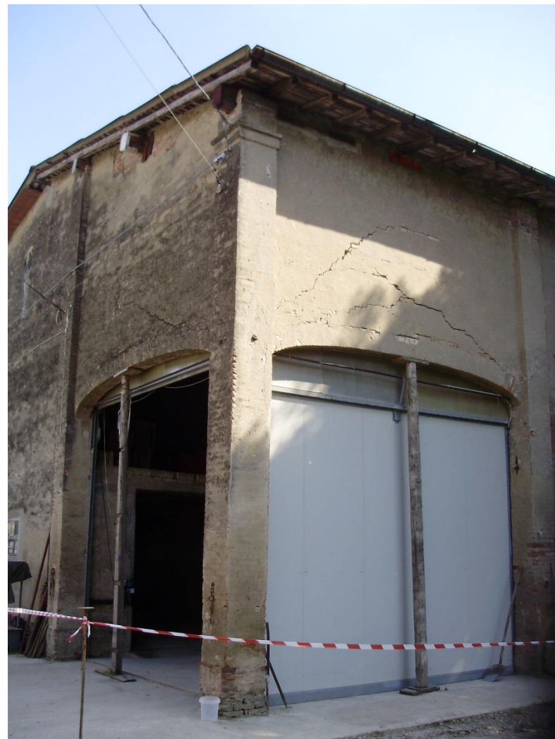
Danno D3/D4-fessurazioni per cedimento archi
