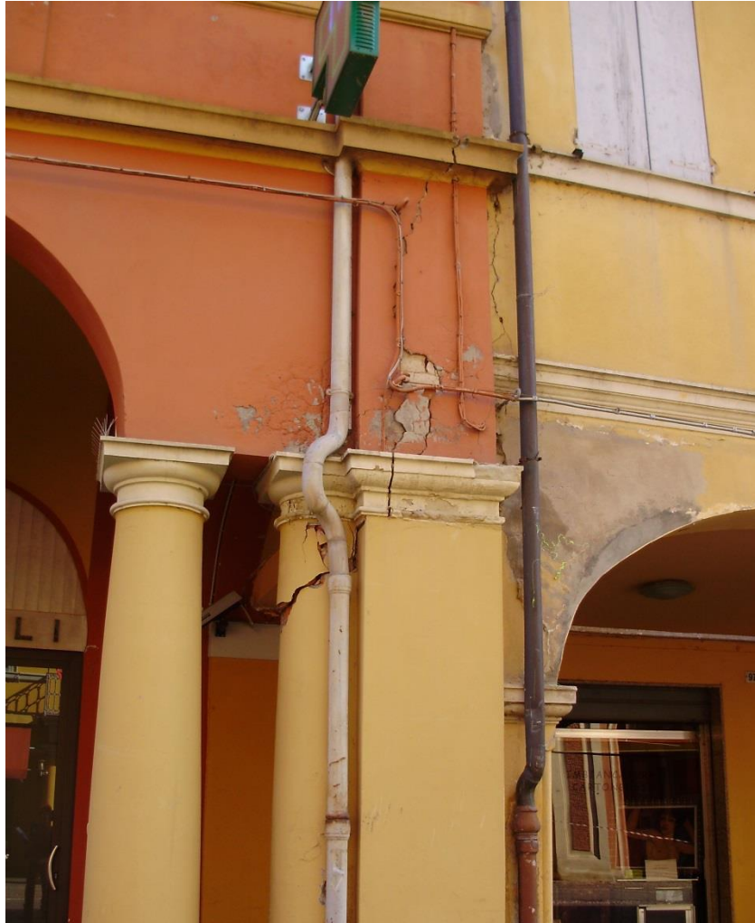
Danno D3-lesione diagonale su struttura in muratura
