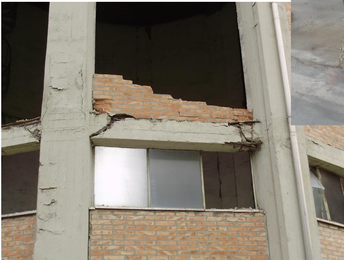
Danno D3/D4-telaio in c.a.
