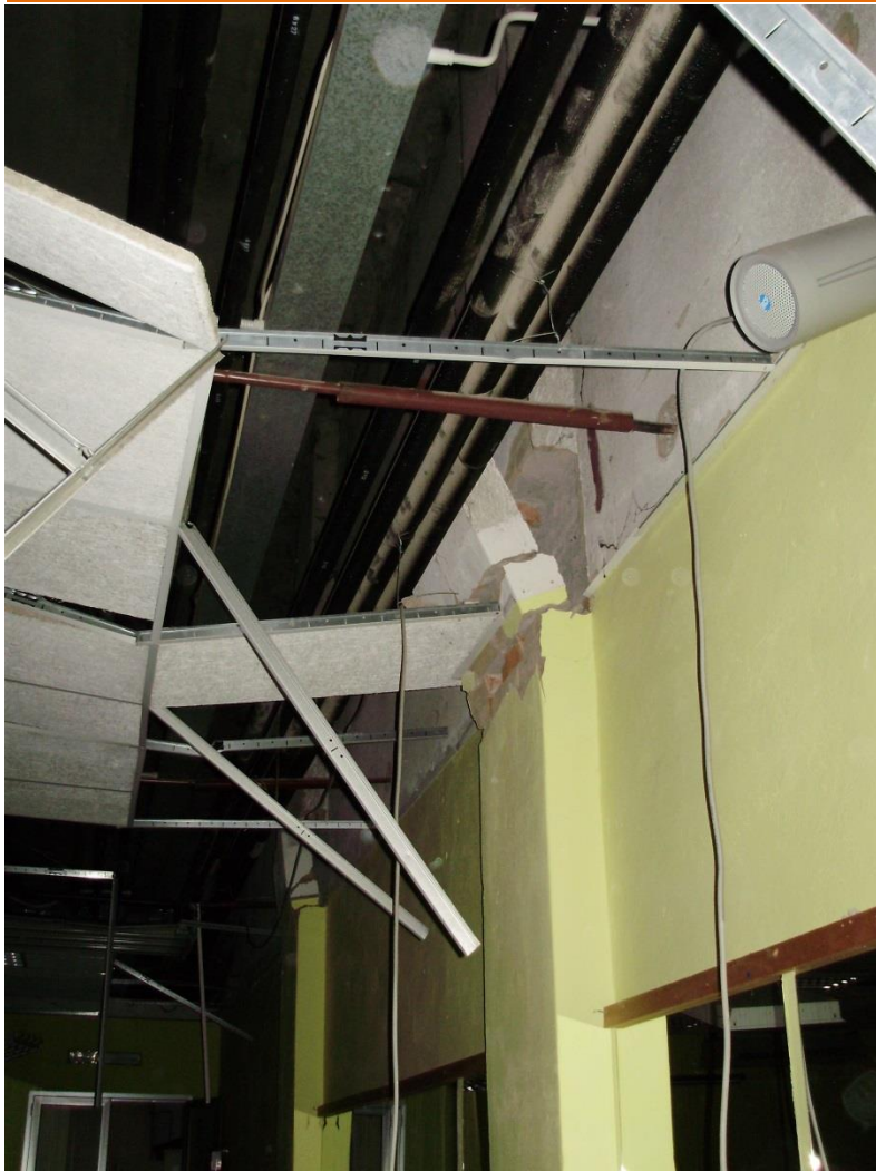
Distacco rivestimenti e controsoffitti
