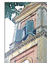
Figura 3 - Elementi pericolanti alla base della cella campanaria del campanile di Sant'Agostino; anche le persiane pericolanti dovrebbero essere preventivamente rimosse operando a distanza.
