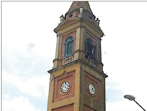
Figura 2 - Danni alla cella orologiaia e campanaria del campanile di Sant'Agostino in seguito al sisma del 20 maggio 2012
