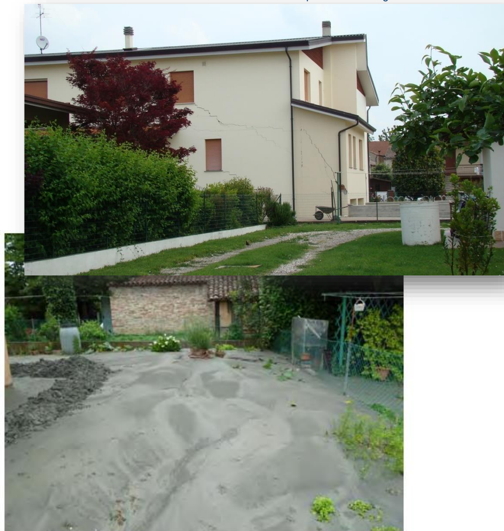
Fig. 9 – San Carlo. Cedimento differenziale di un edificio misto in c.a. e muratura per liquefazione con sviluppo di lesioni di livello 3. A destra, poco lontano, evidenze di liquefazione di sabbie eiettate da un pozzetto.
