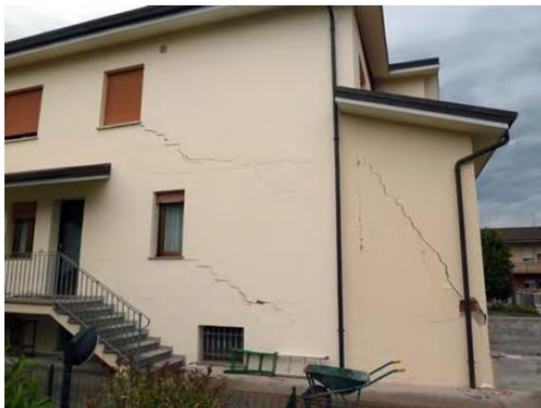
Fig. 9 – San Carlo. Cedimento differenziale di un edificio misto in c.a. e muratura per liquefazione con sviluppo di lesioni di livello 3. A destra, poco lontano, evidenze di liquefazione di sabbie eiettate da un pozzetto.
